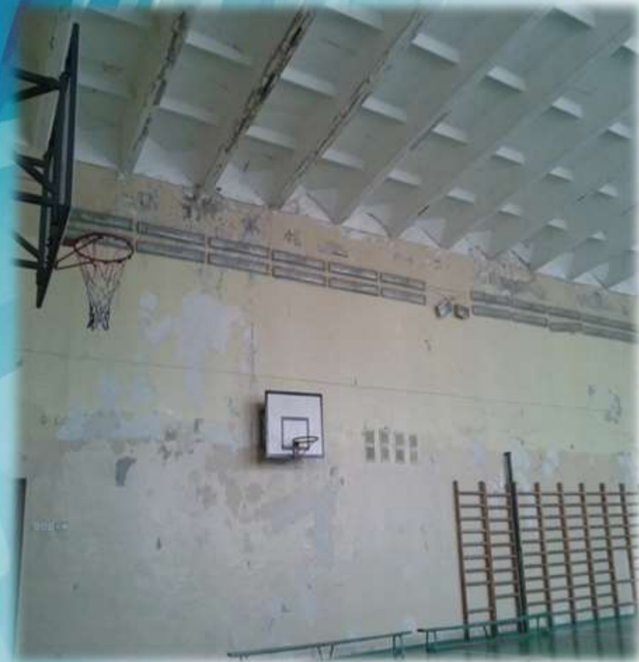
Большой спортзал до ремонта
