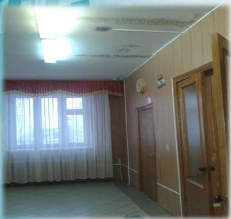
Коридор 4 этажа до ремонта
